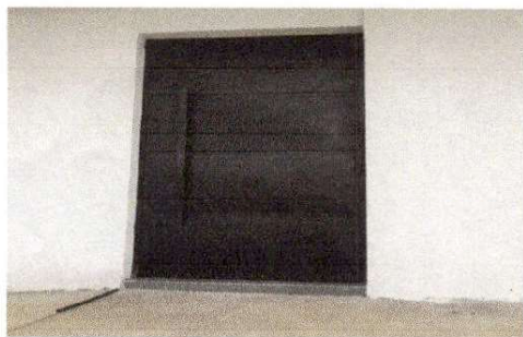
Foto 3: sustitución de puerta
