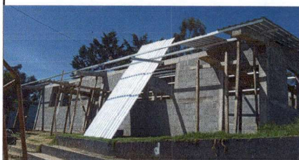
Foto 2: Sustitución de lámina
